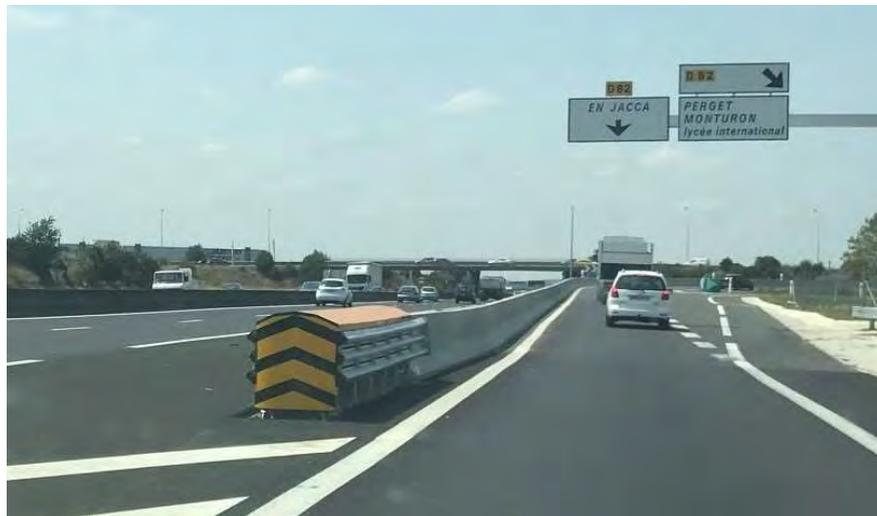
La famille d'atténuateurs de chocs SOLOSMART est basée sur la nouvelle technologie brevetée d'absorption d'énergie par tube dénommée EAP.
