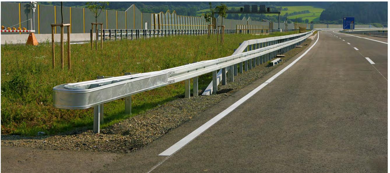
L'extrémité ancre le linéaire de glissières et remplace les musoirs et les extrémités abaissées qui présentent un risque de tremplin pour un véhicule en perdition.
